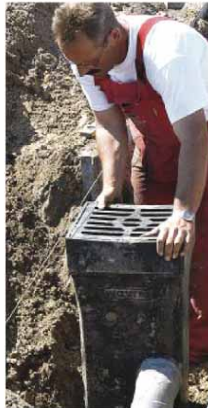
plaatsen van een straatkolk
