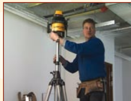
Plafond- en Wandmonteur
